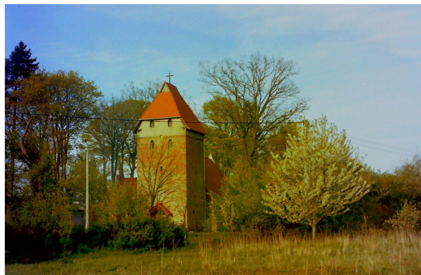
Ryc. 22. Kościół (tylko sama wieża z 1356r.) stanął już przy „nowym, dzisiejszym” przebiegu drogi Ustka- Słupsk. 2021.
