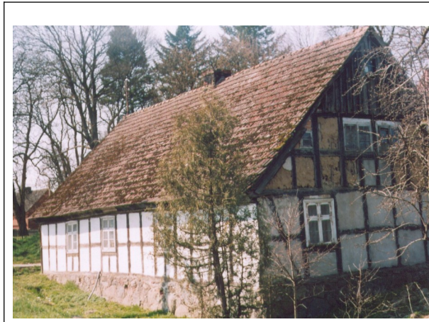
Ryc. 26. Duninowo, dom mieszkalny, lato 2004.
