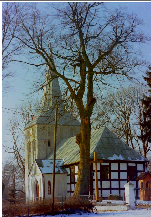
Fot. 57. Wytowno, widok na kościół pw św. Franciszka z Asyżu, od południowego wschodu
