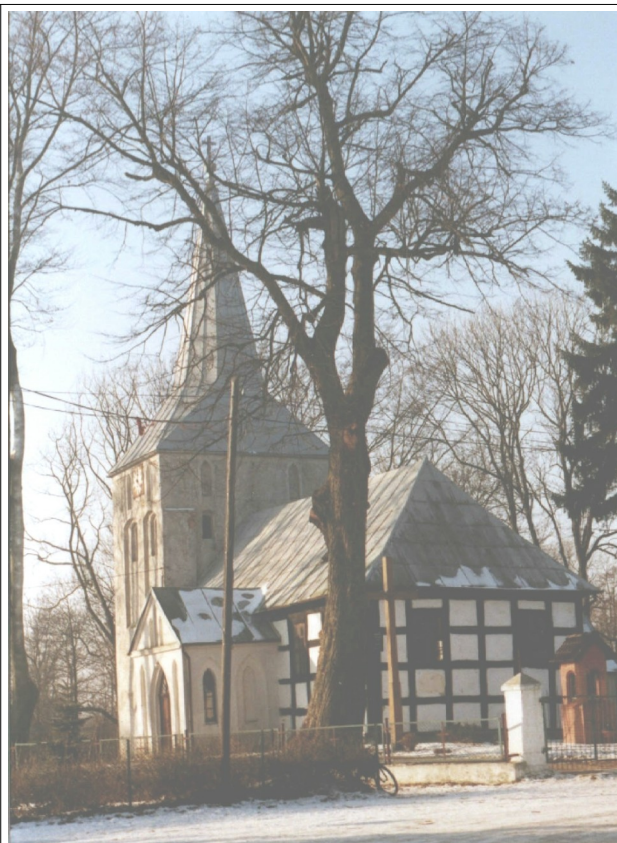
Fot. 45. Wytowno, widok na kościół pw św. Franciszka z Asyżu, od południowego wschodu Fot. Władysław Goliński
