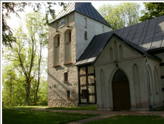
Fot. 43. Wytowno, widok na kościół pw św. Franciszka z Asyżu, od południowego- wschodu Fot. Władysław Goliński
