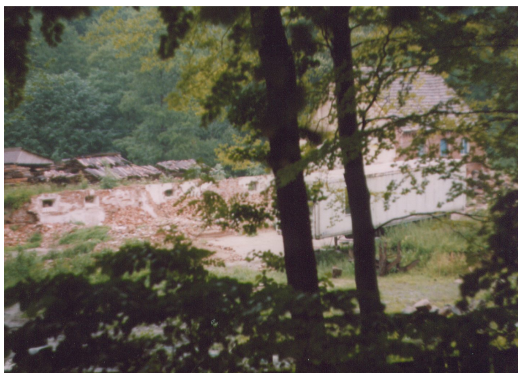
Zamełowo- prace renowacyjne, lato 2004
