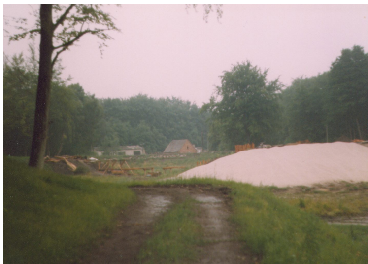
Zamełowo- prace renowacyjne, lato 2004
