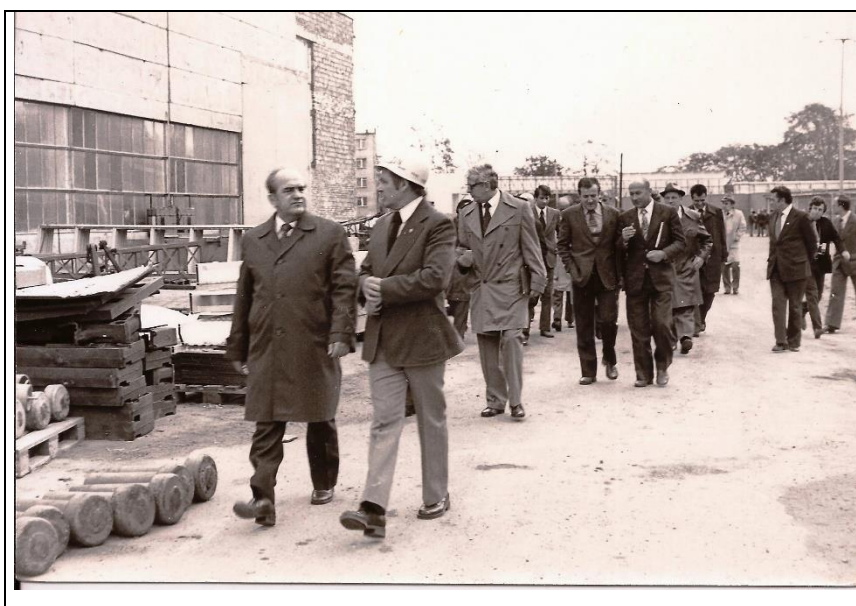
Ryc. nr 199. Delegacja na terenie „B” przy hali U1B w budowie.
