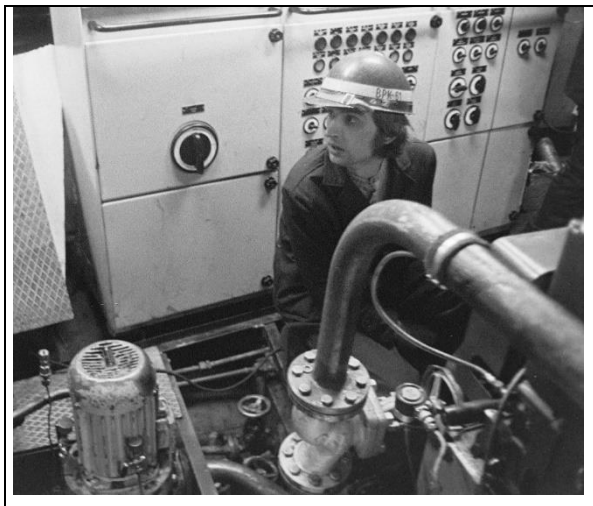
Ryc. nr 124. Wojciech Duch w pomieszczeniu siłowni B410.
