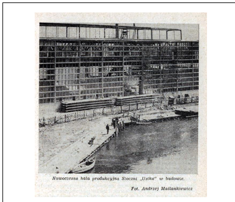
Ryc. nr 63. Budowa hali kadłubowej na terenie „A”.
