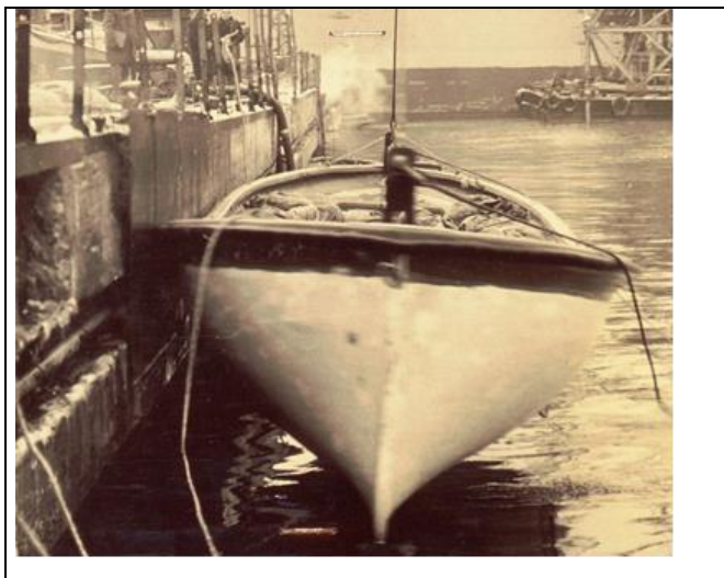
Ryc. nr 31. Łódź w trakcie próby uderzenia o ścianę.
