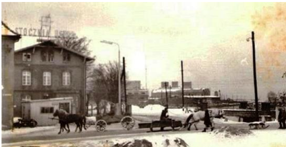
Ryc. nr 47. Budynek administracyjny na terenie „B”.
