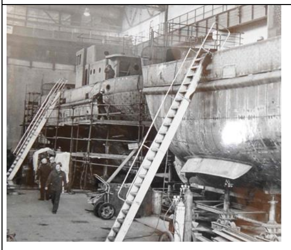
Ryc. nr 95. Hala budowy kadłubów B25sA.
