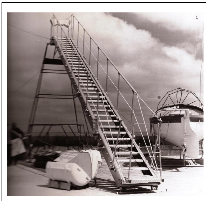
Ryc. nr 45. Trap aluminiowy, obok - skorupa laminatowa tratwy ratunkowej. Po prawej stronie - łódź ratunkowa z tworzyw sztucznych.
