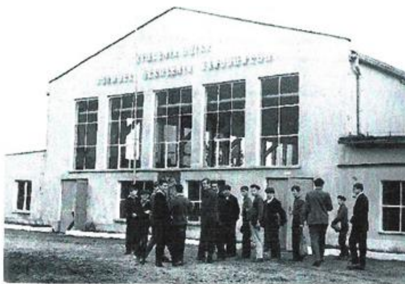
Budynek warsztatów szkolnych 1966r.
