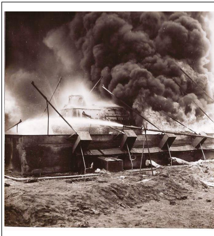
Ryc. nr 82. Druga próba ognioodporności łodzi ŁRT-P1sZZ.
