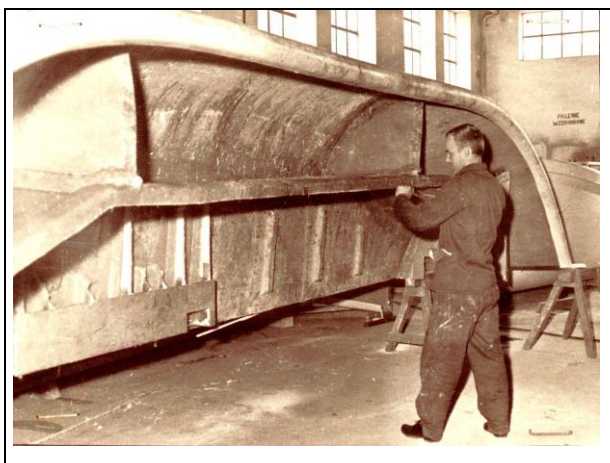
Ryc. nr 24. Obróbka kadłuba łodzi ratunkowej laminatowej.
