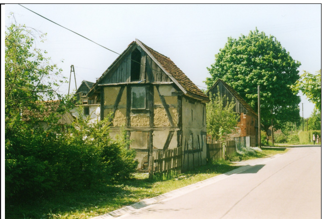
Fot. 7 Droga w Charnowie (wjazd do Charnowa), 2005
